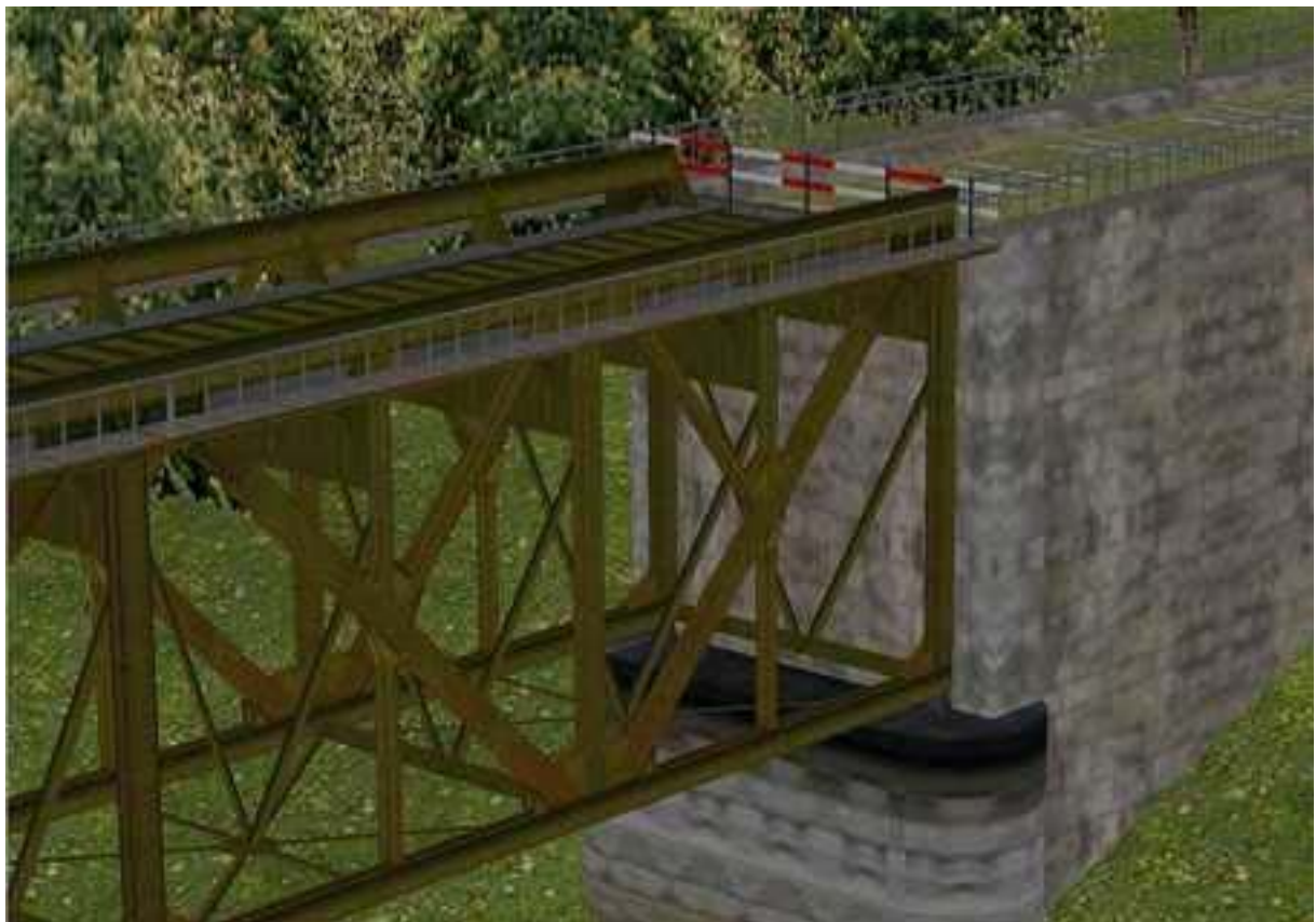
Bennrath_4b_2 Nahaufnahme des Brückenkopfs
