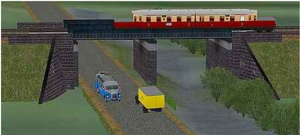
Bennrath_06 quert Straße und Bach.
