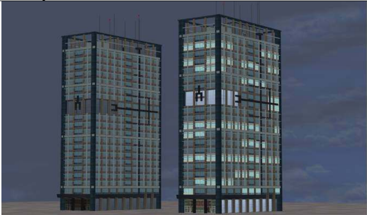
BTC_Geb_31_AF1 und BTC_Geb_31_L_AF1 in Nachtansicht ( BTC_Geb_31_AF1 ist bis auf zwei Antennenspitzen unbeleuchtet).
