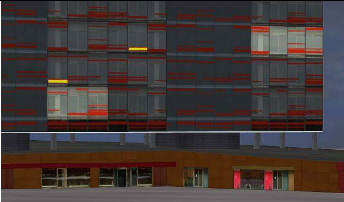
BTC_Geb_27_L_AF1 , BTC_U_27_L_AF1 und BTC_TH_27_AF1 in Nachtansicht vom Innenhof
