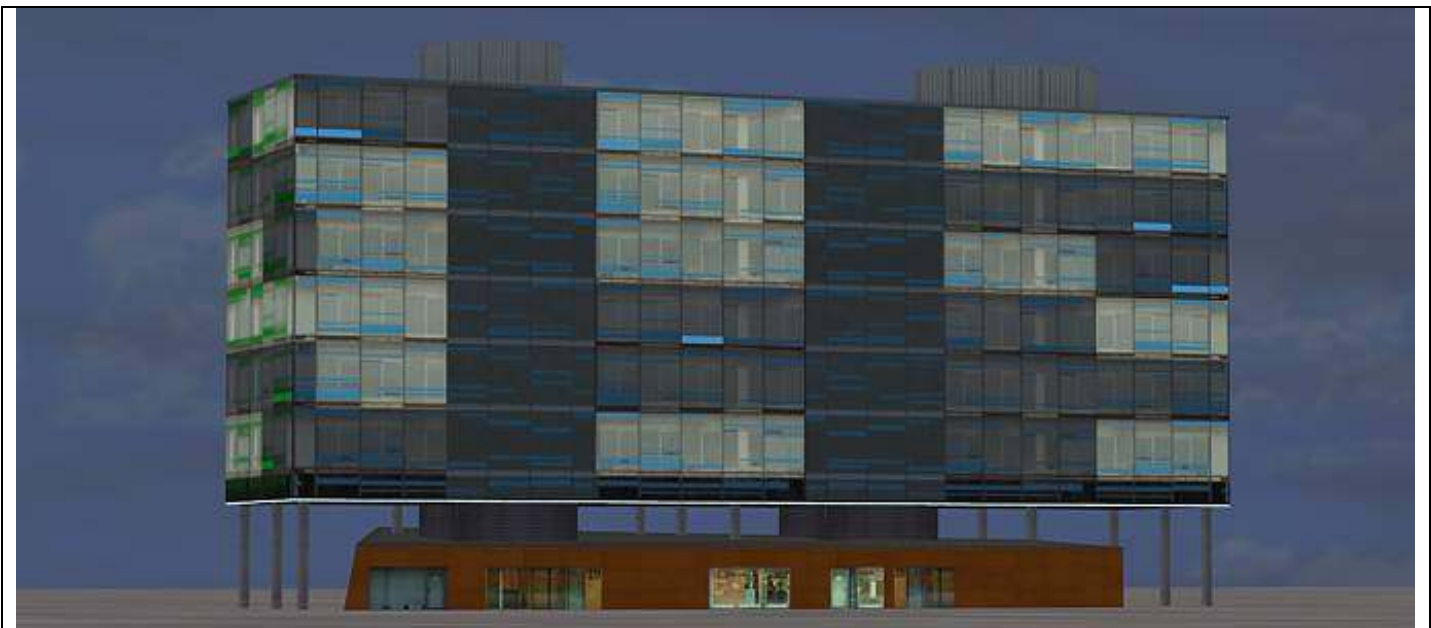
Innenhofseite von BTC_Geb_19_21_L_AF1 , BTC_U_19_21_L_AF1 und BTC_TH_19_21_AF1 in Nachtansicht. Im Bereich der Fahrstuhlschächte liegen im Untergeschoss die Gebäudezugänge.
