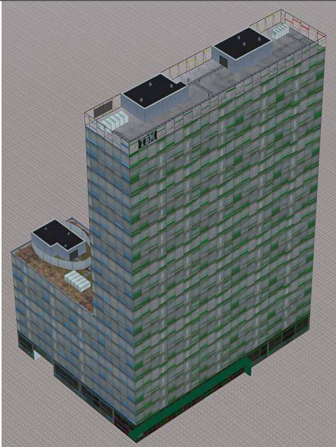
BTC_Geb_17_AF1: L-förmiges Bürohochhaus. Hauptteil Grundfläche ca. 60 x 14 m, Höhe 90 m; Seitenflügel Grundfläche ca. 31 x 19 m, Höhe 34 m. Garagendurchfahrt im Seitenbau. Auf den Dächern angedeutete Betriebseinrichtungen einschl. Klimaanlage. Oberstes Stockwerk des Haupthauses mit durchsichtigen Glasfronten. Ladezeit ca. 0,23 ms
