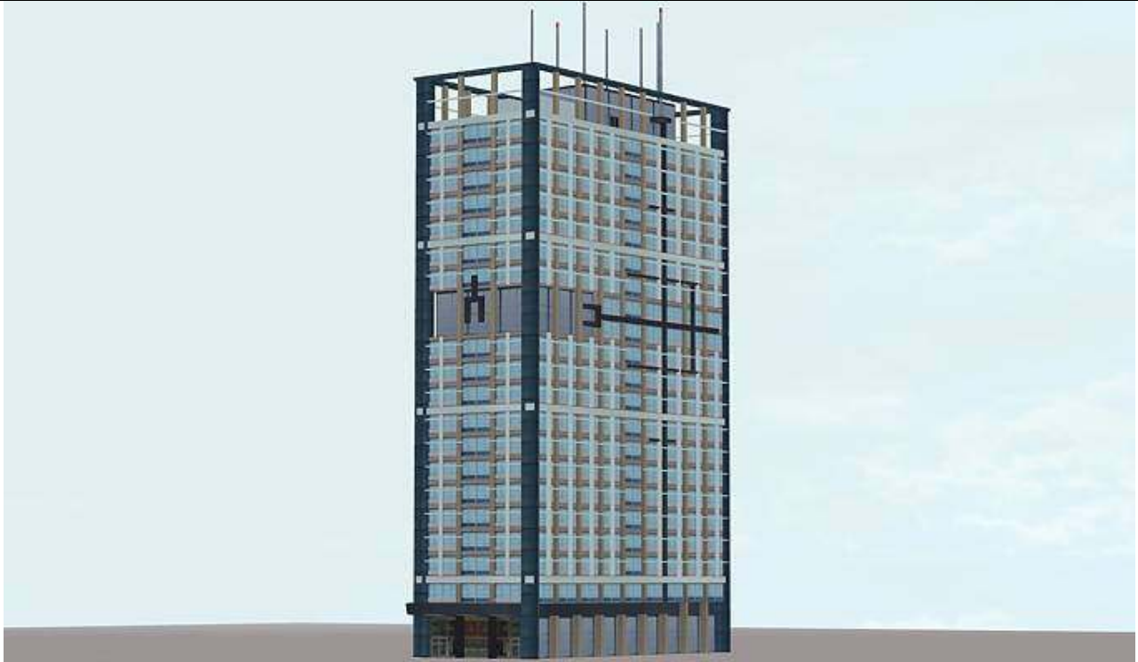
Südostecke BTC_Geb_31_AF1 : Büro-Hochhaus (ehemaliges Polizeipräsidium) Grundfläche ca. 20 x 48 m , Höhe ca. 83 m. Auf dem Dach angedeutete Betriebseinrichtungen einschl. Klima- und Antennenanlage. Ladezeit 0,37 ms.
