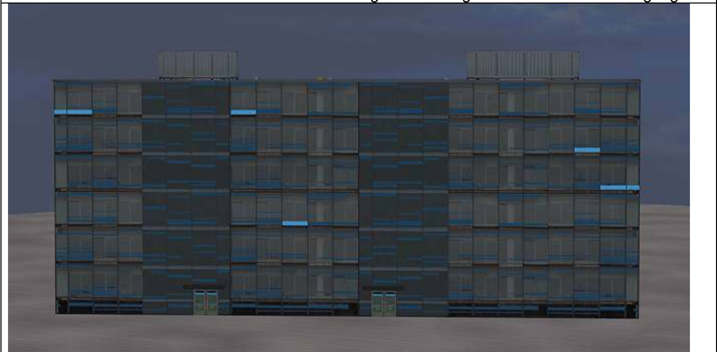
BTC_Geb_19_21_S_AF1 wie BTC_Geb_19_21_AF1 , Einsatz auf Sockel ohne Säulenunterbau / Untergeschoss; Außeneingänge im Treppenhaus-/Fahrstuhlbereich mit beleuchtetem Vordach; Höhe 27 m; Ladezeit 0,07 ms; auch als beleuchtetes BTC_Geb_19_21_L_S_AF1 vorhanden.
