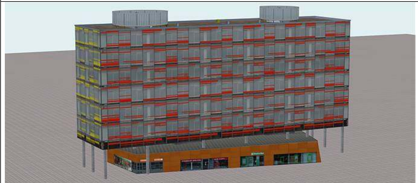
Straßenfront von BTC_Geb_19_21_AF1 : Sechsstöckiges Bürohaus mit separatem Untergeschoss BTC_U_19_21_AF1 und Fahrschachtt BTC_TH_19_21_AF1 . Grundfläche ca. 60 x 14 m, Höhe ca. 33 m. Auf dem Dach angedeutete Betriebseinrichtungen einschl. Klimaanlage. Ladezeit 0,16 ms.
